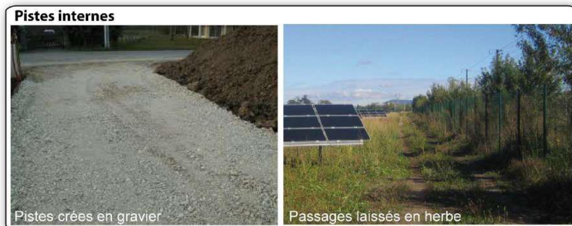
Figure 34 : Pistes internes (Source : PHOTOSOL)
