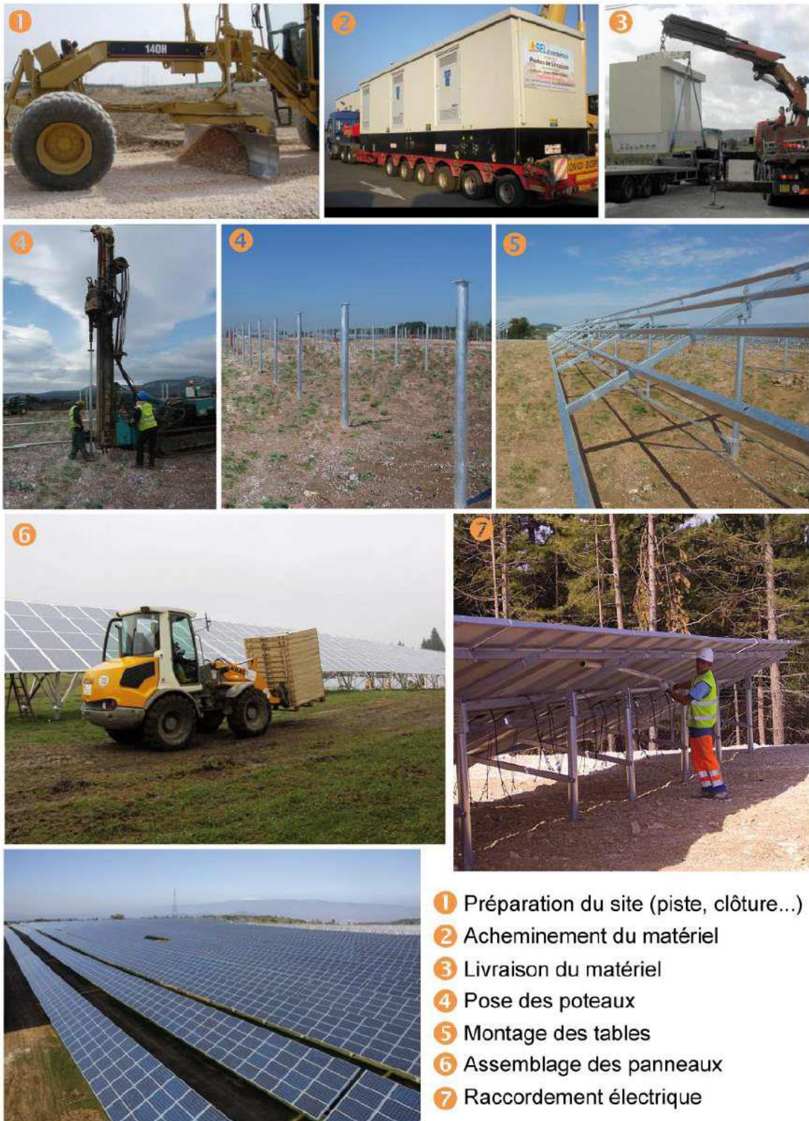
Figure 36 : Synthèse photographiques des principales étapes de construction d'une centrale photovoltaïque (Source : PHOTOSOL)
